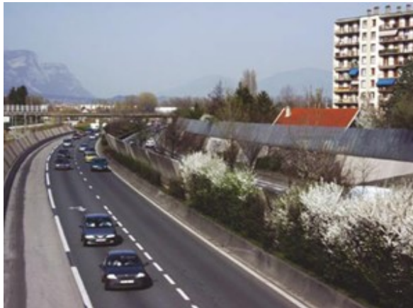
Des murs antibruit permettent de limiter les nuisances sonores pour les riverains proches des axes à grande circulation.
